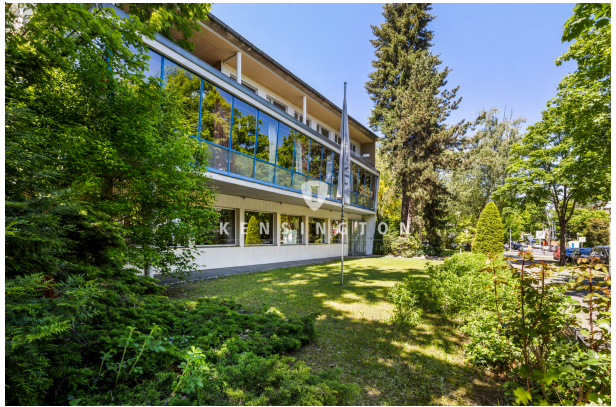
Grundstück mit Abrissgebäude
