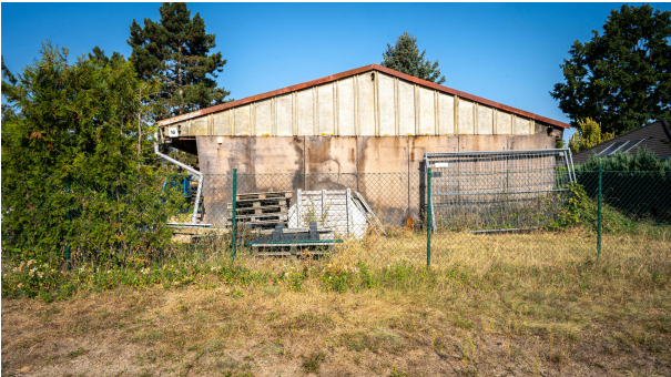
Straßenansicht mit Abrissobjekt
