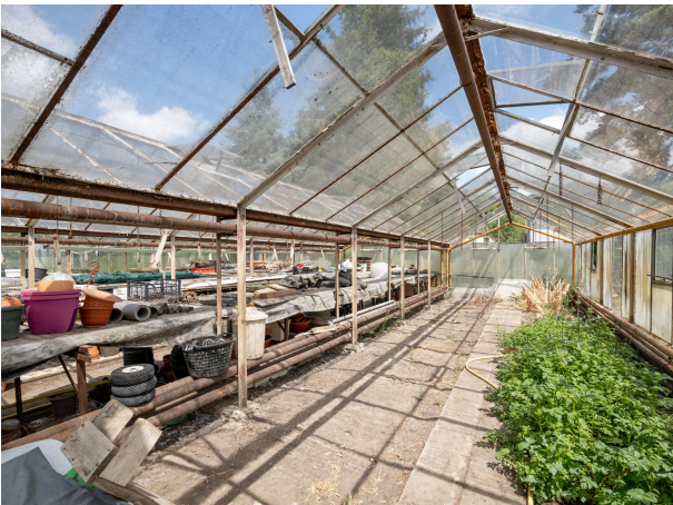
Abrissobjekt / Treibhaus - voll unterkellert
