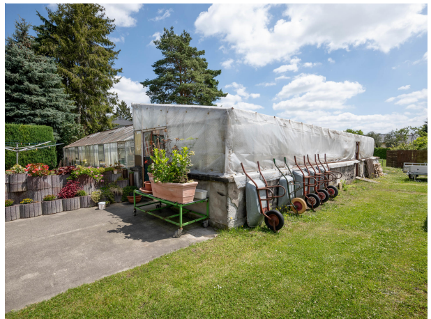
Abrissobjekt / Treibhaus - voll unterkellert
