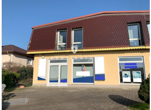
Ansicht Neubau straßenseitig
