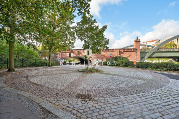
Brücke über die Spree
