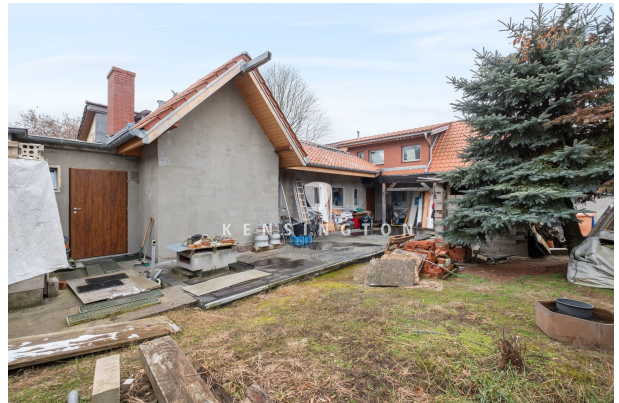
Terrasse (noch nicht fertig)
