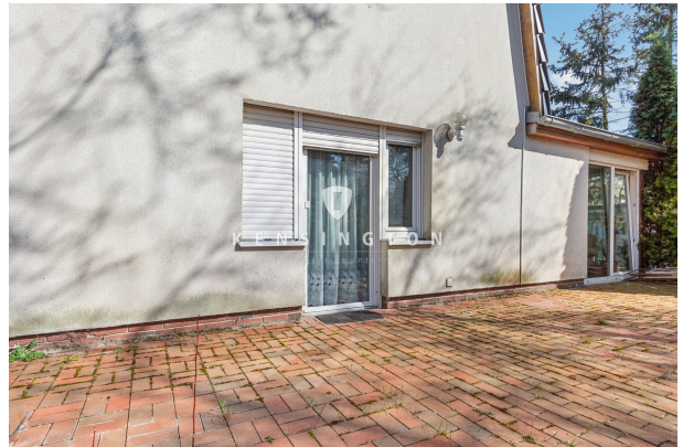
Terrasse hinter dem Haus
